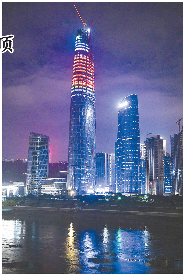
↑6月17日晚拍摄的建设中的重庆陆海国际中心项目。
