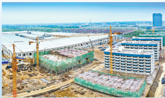
弗迪动力电池项目火热施工
