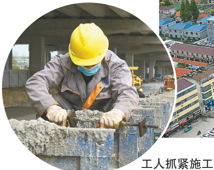
工人抓紧施工。
