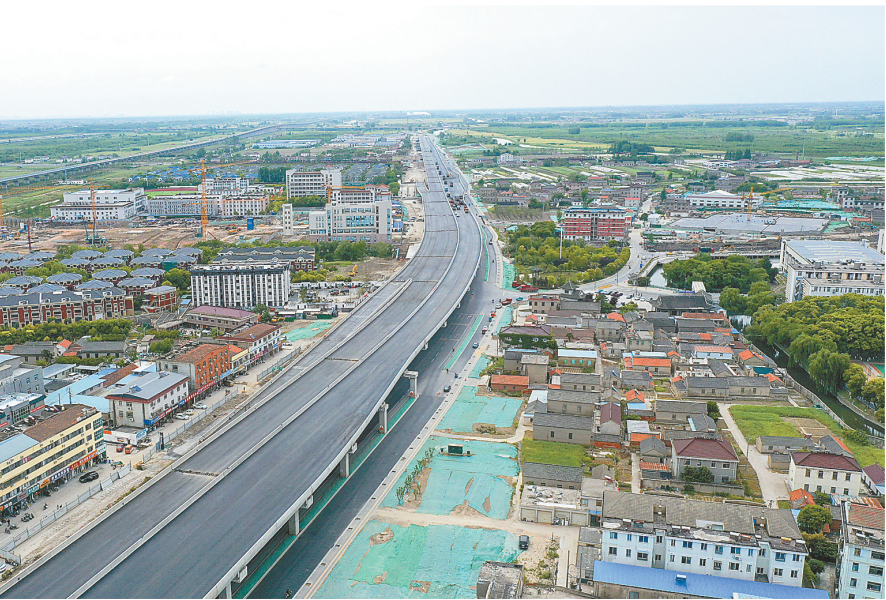
5月15日,盐丰快速通道一期工程施工现场。
