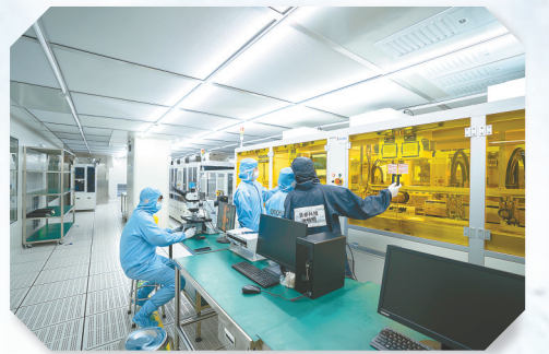
人民百业科技公司一期厂房无尘车间
