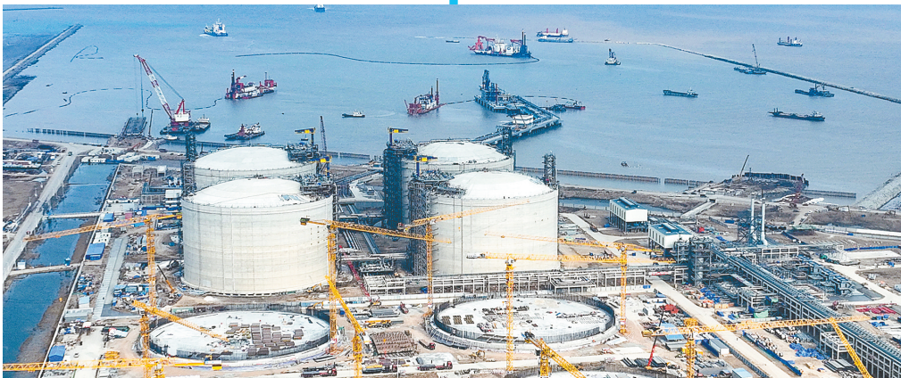
滨海LNG项目
