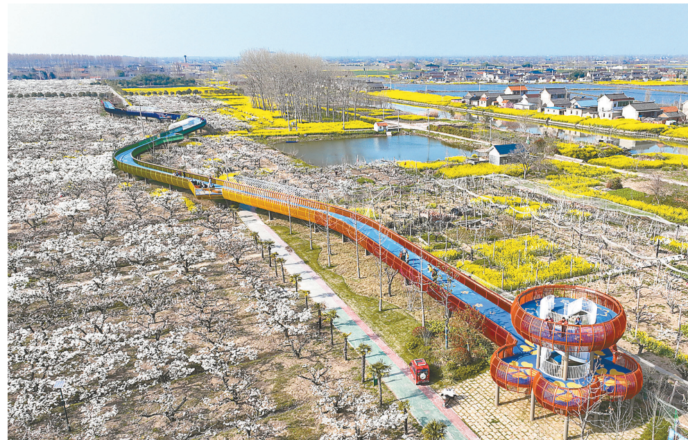
3月29日下午，从空中俯瞰盐都区龙冈桃园景区，新建成的空中栈道在花海中心显得格外美丽。龙冈桃园核心区项目，规划面积1.2平方公里，作为盐都区城北地区改造的重点项目之一，各项进度正如火如荼推进。
