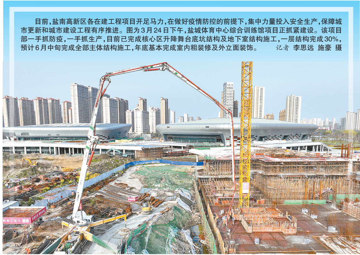
目前，盐南高新区各在建工程项目开足马力，在做好疫情防控的前提下，集中力量投入安全生产，保障城市更新和城市建设有序推进。图为3月24日下午，盐城体育中心综合训练馆项目正抓紧建设。该项目一手抓防疫，一手抓生产，目前已完成核心区升降舞台底座结构及地下室结构施工，一层结构完成30%，预计6月中旬完成全部主体结构施工，年底基本完成室内精装修及外立面装饰。 记者 李思远 施豪 摄
