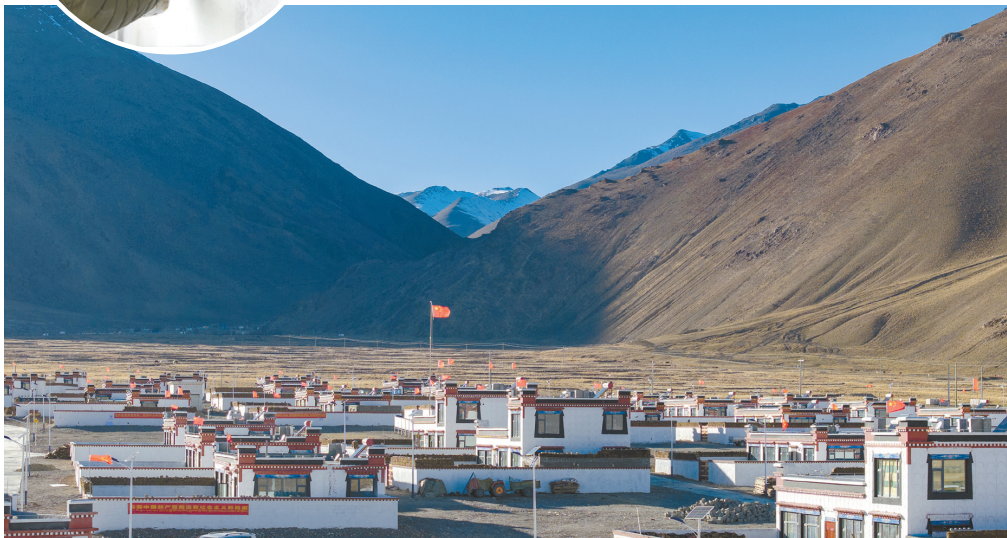
个西藏定日县措果乡野江村建成并交付群众使用的新房(11月12日摄,无人机照片)。新华社记者 姜帆 摄
