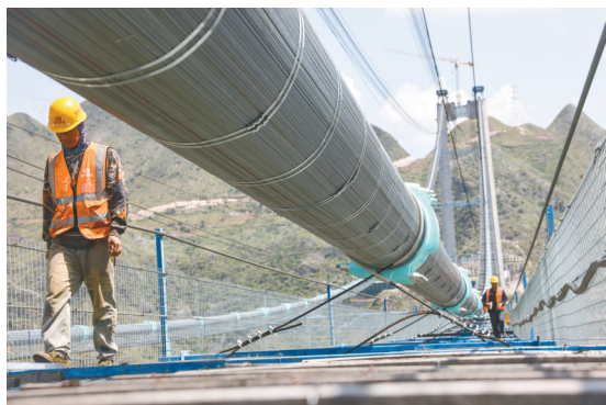
↑2024年9月4日,工人在贵州花江峡谷大桥的猫道上施工。 新华社记者 欧东衢 摄
