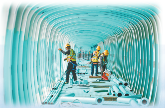
↑2025年6月11日,工人在贵州花江峡谷大桥上安装观景长廊。 新华社记者 杨文斌 摄
