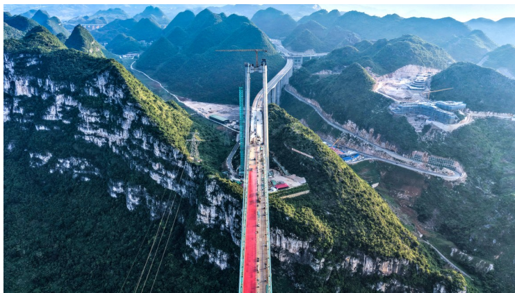
这是6月11日拍摄的贵州六安高速花江峡谷大桥(无人机照片)。新华社记者 杨文斌 摄
