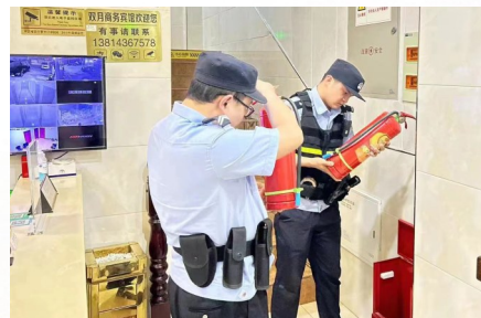
检查消防设备
