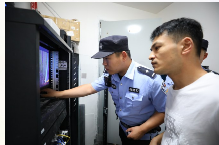
检查安防设施
