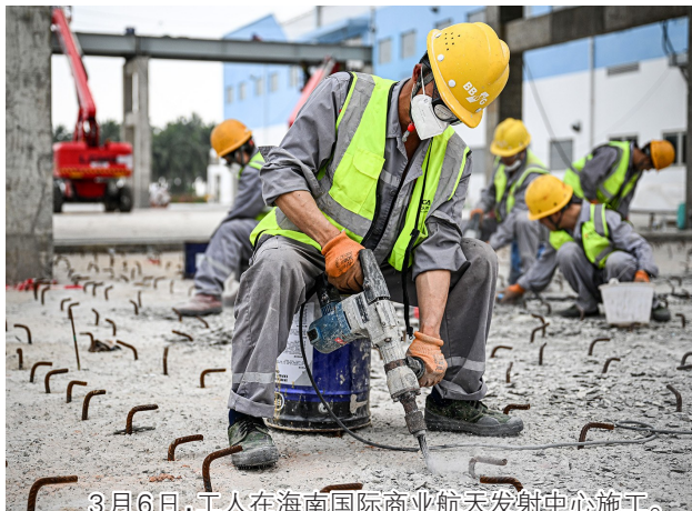
3月6日,工人在海南国际商业航天发射中心施工。
