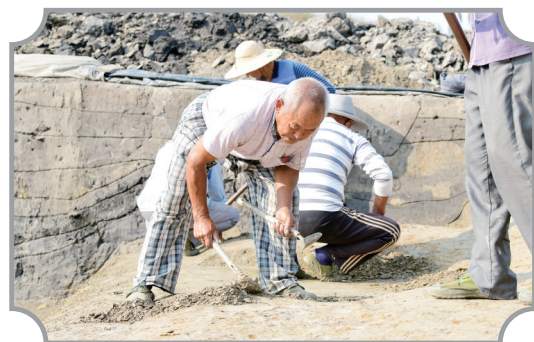
工人师傅在现场清理浮土。
