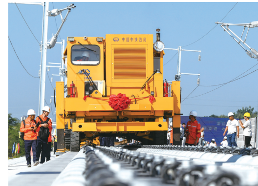
9月6日,在四川省泸州市冯湾特大桥施工现场,智能铺轨机在进行铺轨施工。当日,在四川省泸州市冯湾特大桥施工现场,随着第一组500米长的钢轨稳稳落下,渝昆高铁川渝段全面进入铺轨阶段。 新华社记者 王曦 摄
