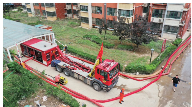
8月7日,邯郸市消防救援支队排水设备在河北省涿州市一小区地下车库排涝现场作业(无人机照片)。 新华社记者 牟宇 摄
