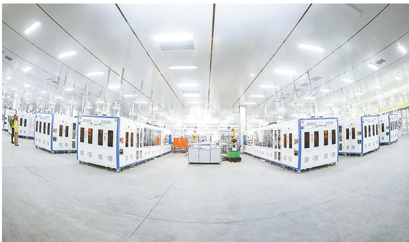
晶澳10GW光伏电池、10GW光伏组件及配套项目
