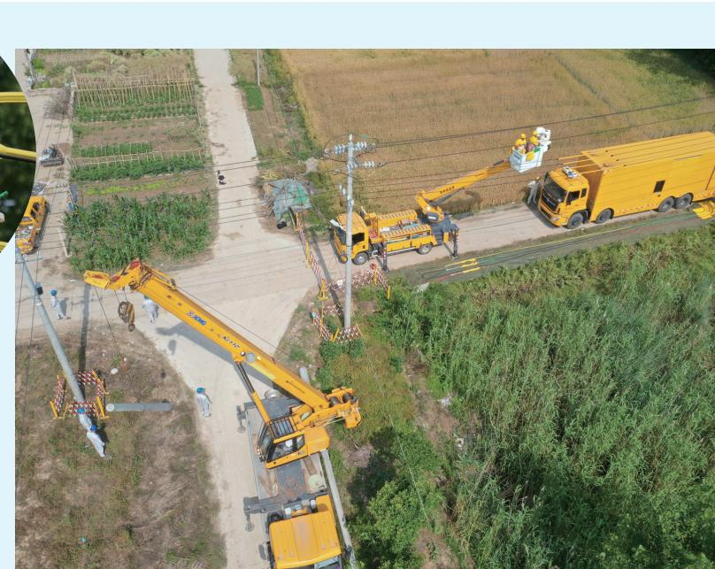
近日,滨海供电公司通榆镇三埝村境内组织防汛应急联动机制演练活动。本次活动主要是模拟汛期河水陡增导致沿河10千伏线路发生倒杆断线事故,采取10千伏负荷转供、中压发电车发电等措施,建立防汛应急联动机制,保证居民用户正常供电。周吉成 摄
