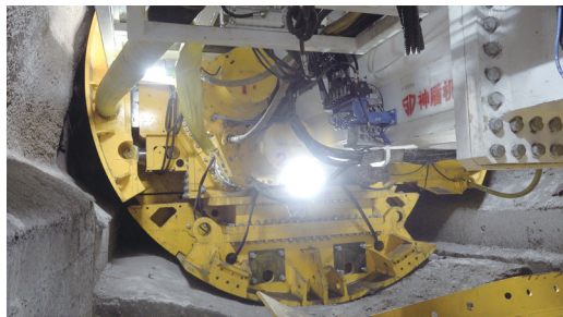
图为“奋进号”硬岩掘进机开启带负荷运转。李琼西 摄
