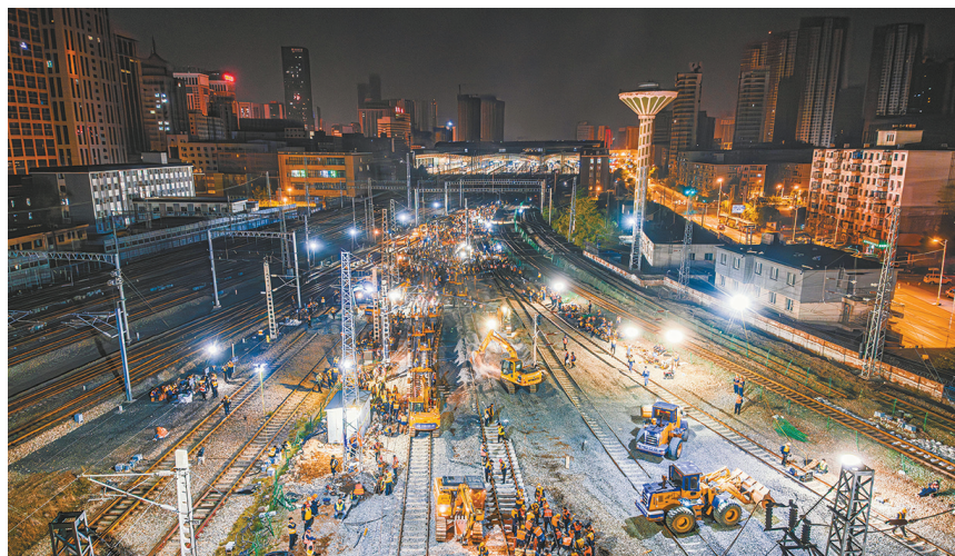
5月25日拍摄的沈白高铁并入沈阳北站施工现场(无人机照片)。5月25日10时30分,经过3000余名铁路职工连续奋战,沈白高铁并入沈阳北站第一阶段施工顺利完成。沈白高铁是国家中长期铁路网东北东部快速铁路通道的重要组成部分,正线全长430.1公里,设计时速350公里。
