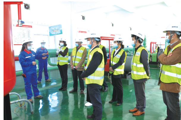
参观上冈油库消防泵房。 黄海峰 摄
