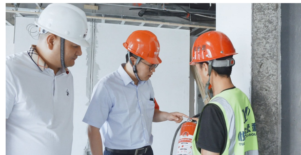
图为悦达天惠置业有限公司安全员向项目施工人员讲解灭火器的具体使用方法。张来金 摄
