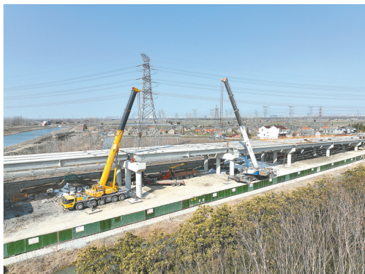
省淮河流域重点平原洼地治理工程建湖境内工地
