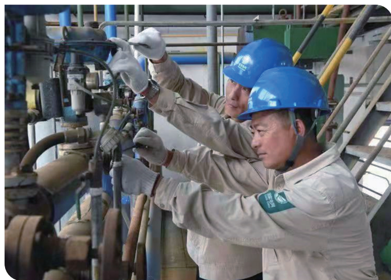
图为检查现场。(盐城供电公司供图)
