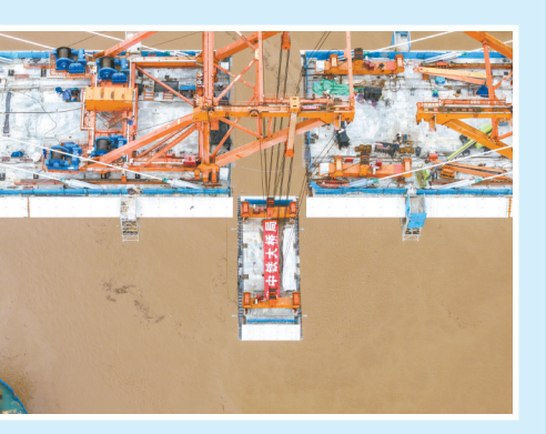
5月26日,渝万高铁石沱长江大桥建设现场,施工人员在吊装最后一段钢混组合梁(无人机照片)。新华社记者 唐奕 摄
