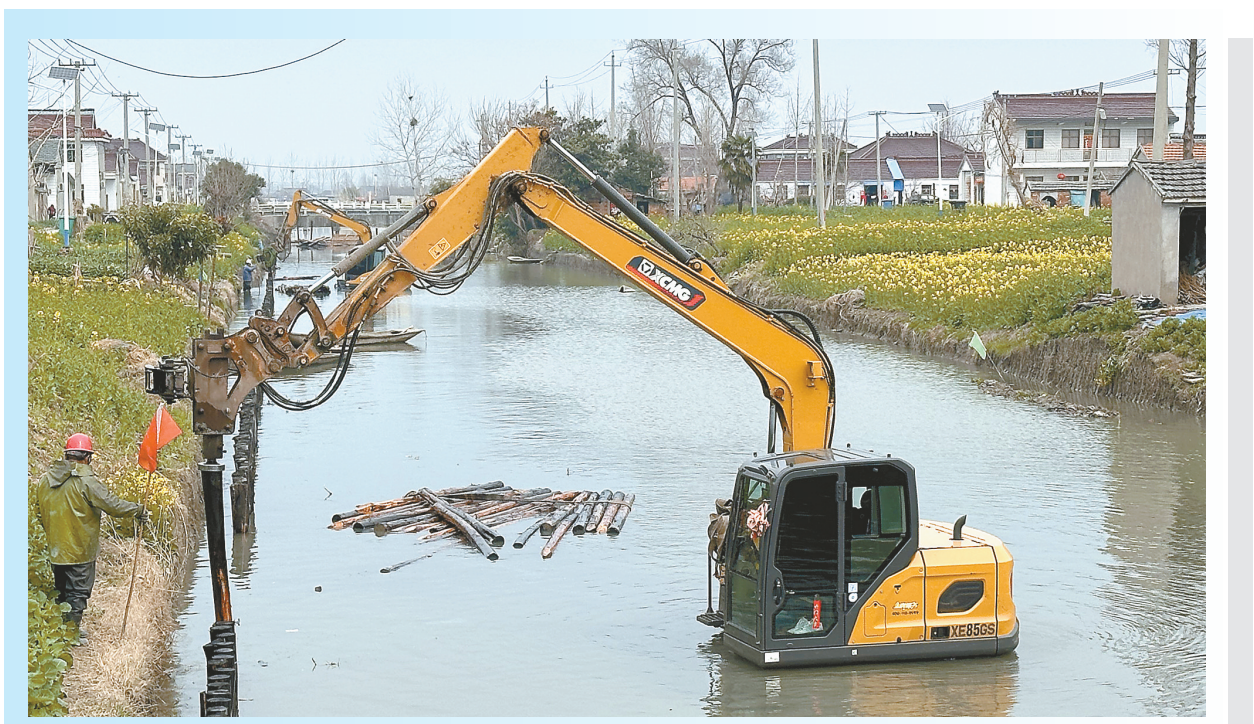
3月11日,大丰区白驹镇东窑村生态河道治理工地上,施工人员正在进行木桩护坡施工。今年该镇第一批农村河道生态治理工程涉及3条河道,治理总长度10.13公里。徐友权 程旭权 朱军 摄
