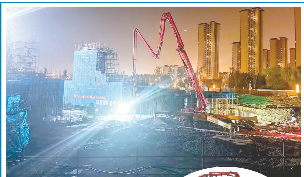
日前,在城市防洪排涝补短板工程施工现场,混凝土搅拌车有序进出、穿梭不息,泵车长臂舒展、精准浇筑,各工序衔接紧密、运转高效。目前小新河堰站、西潮河调节点工程已顺利通过完工验收,串场河南闸站工程于2月初完成水下验收,工人们铆足干劲,全力推进串场河南闸站工程启闭机房、高低压室等后续施工,以坚守与实干,为城市筑牢一道坚实的防洪排涝“安全屏障”。 施水宣 摄
