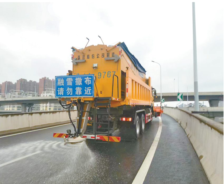
养护人员驾驶综合除雪车向快速路面撒布融雪剂。记者 宋晓华 摄
