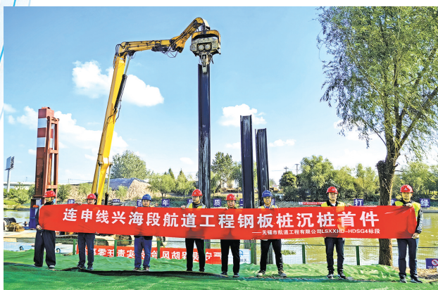
连申线兴海段航道工程钢板桩沉桩首件
