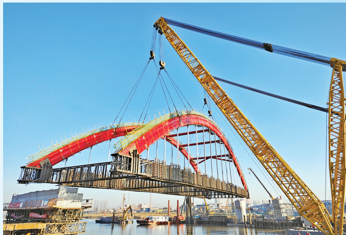
连申线灌黄段双园大桥吊装施工
