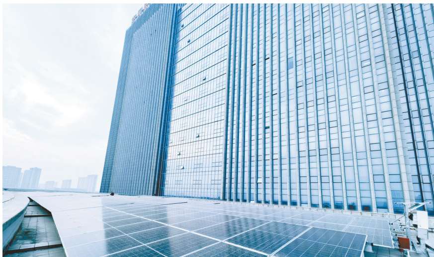
大丰区市民中心南裙楼屋顶300kW分布式光伏于2025年12月并网发电,全市共新增6个公共机构分布式光伏项目。
