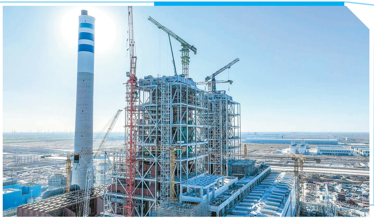
连日来,国电投滨海2×100万千瓦火电扩建项目现场一派热火朝天的景象,建设者们严守安全质量底线的前提下争分夺秒推进项目建设。据悉,项目建成投产后将有效提升江苏电源供应可靠性,并发挥基础性、支撑性调节作用,满足用电负荷增长需求,同时为江苏和华东电网“北电南送”电力大动脉的长期、高效、稳定运行提供重要支撑和保障。 刘伟 记者 张一轩 摄
