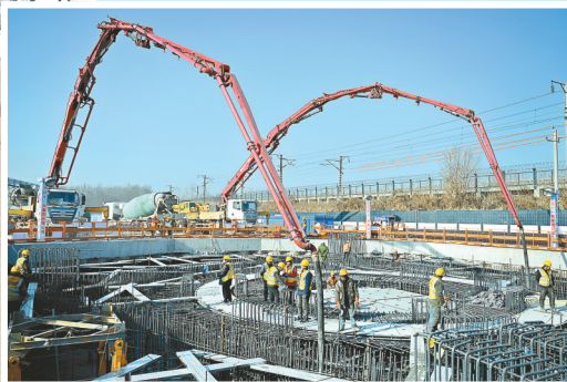
12月23日,中铁十一局工人在石雄铁路跨黄铁路特大桥176号墩转体桥承台浇筑现场作业。新华社记者 牟宇 摄
