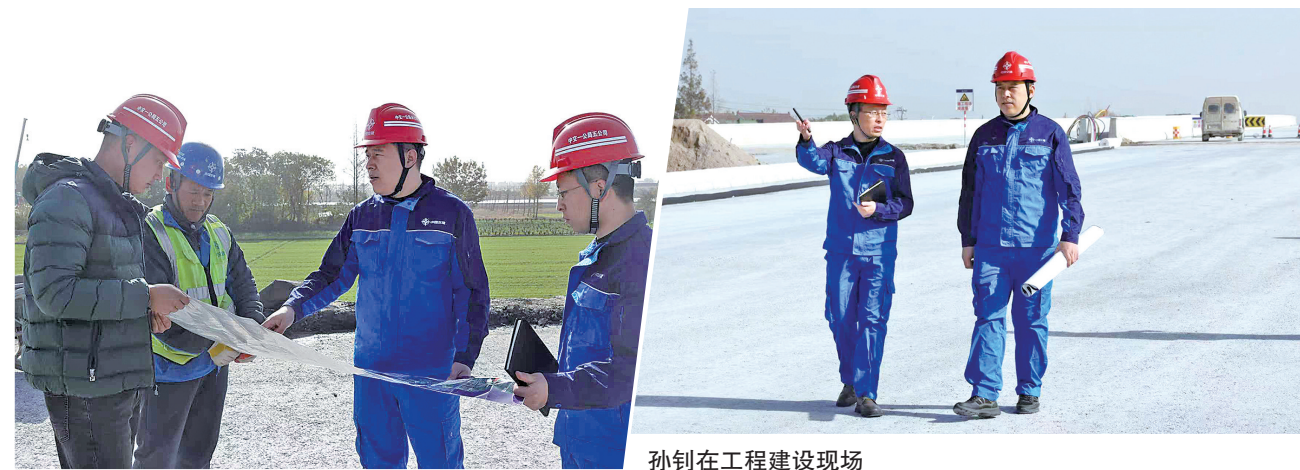
孙钊在工程建设现场
