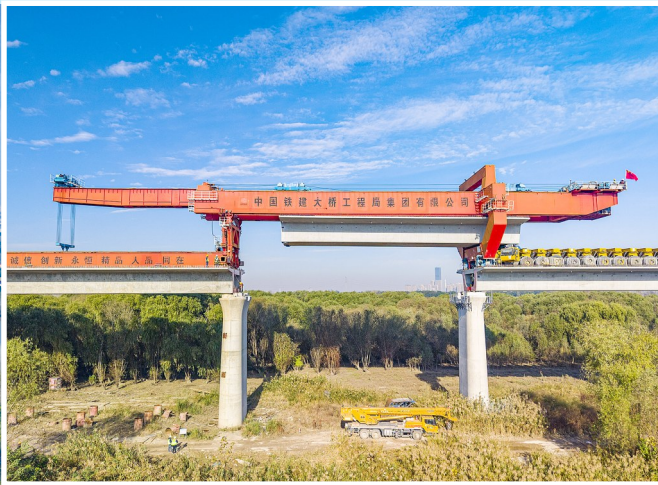
11月20日，中铁建大桥局施工机械在沪渝蓉高铁江都段最后一榀箱梁架设现场作业(无人机照片)。 当日，随着最后一榀箱梁精准架设至预定位置，沪渝蓉高铁江都段箱梁架设完成。 新华社发(任飞摄)
