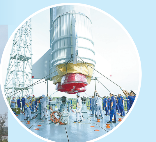
11月11日,发射场工作人员对长八甲遥五火箭进行吊装作业。
