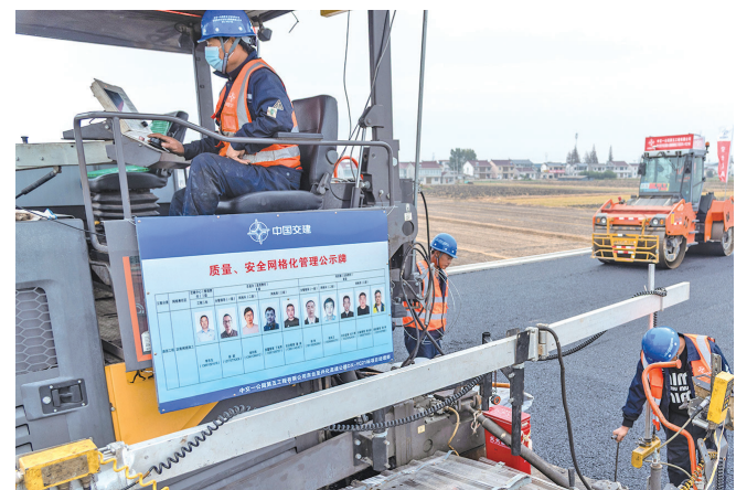
工人们在施工
