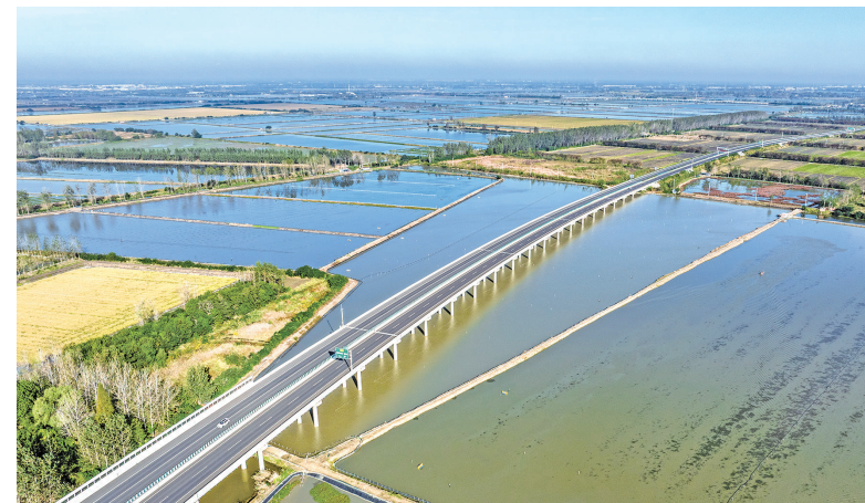
近日,在江苏省建兴高速盐城段,秋阳映照下的高速公路与沿途景致美不胜收。建兴高速是南北贯通江苏腹地的阜溧高速公路(S35)的一部分,连接建湖县和兴化市,全长71.72公里,全线三分之二的路段建在水上,故有“水上高速”之称。
