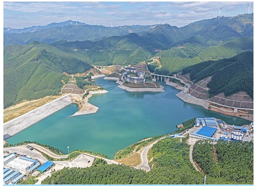
这是10月25日拍摄的南宁抽水蓄能电站库区(无人机照片)。近日,广西南宁抽水蓄能电站的上水库工程顺利通过蓄水前验收。这标志着南宁抽水蓄能电站主体土建工程已全面完成,为实现今年年底全部机组投产目标奠定基础。南宁抽水蓄能电站是“十四五”规划中的重大工程之一,于2022年7月启动建设,总装机容量120万千瓦。 新华社记者 周华 摄
