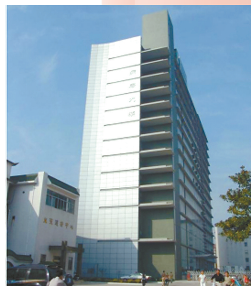
2005年3月,13层病房楼竣工启用。
