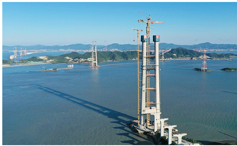
9月6日,由中国铁建大桥局参建的浙江宁波舟山港六横公路大桥二期工程首个主塔——双屿门特大桥东主塔封顶,标志着大桥建设取得突破性进展,为后续全面进入上部结构施工奠定坚实基础。
