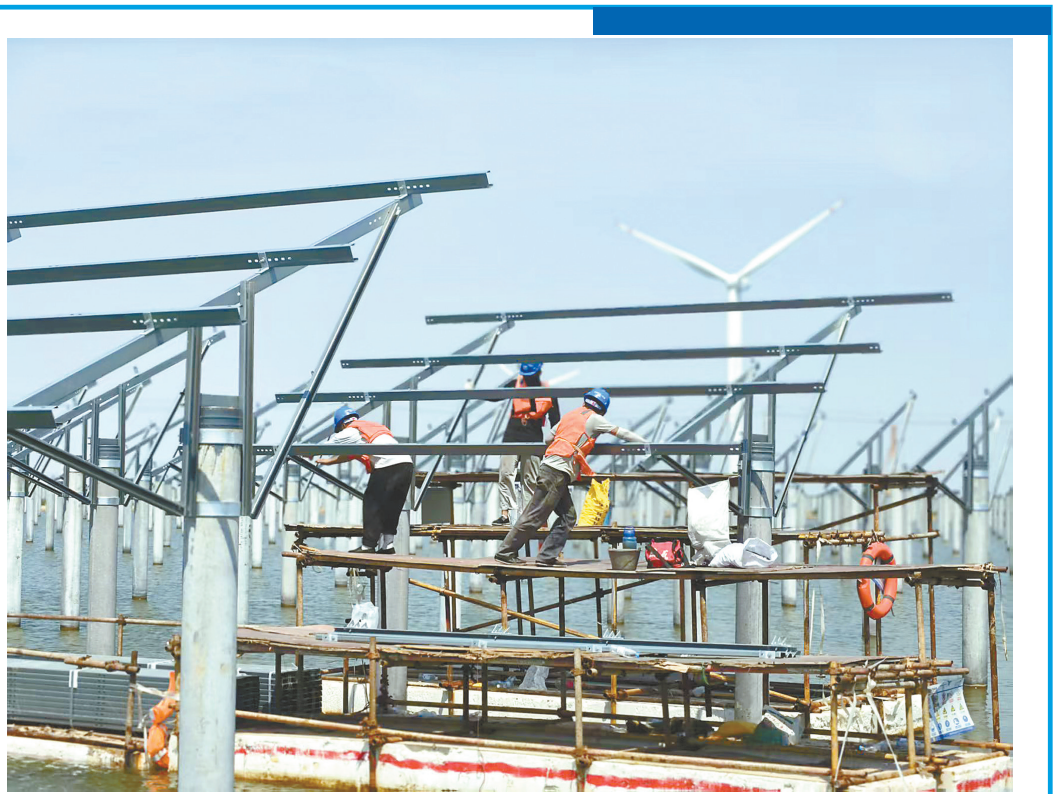
8月21日,在黄海新区420MW渔光互补发电项目现场,工人们正在紧密协作安装光伏支架组件,确保工程进度与质量同步推进。据悉,该项目由海兴控股集团与悦达集团合资建设,目前已进入关键施工阶段,全面建成后,每年平均发电量约为61382万kWh,兼具生态与经济效益,是绿色发展的创新实践。刘隽华 记者 刘谦 摄
