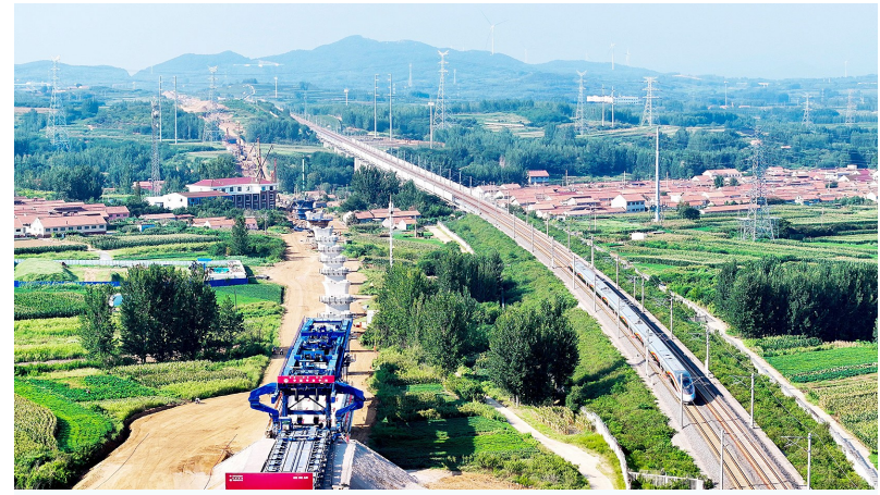
8月22日,淮(坊)宿(迁)高铁至青岛连接线1标段首榀箱梁架设成功,标志着淮宿高铁至青岛连接线全部4个标段进入全线架梁施工阶段。据悉,淮宿高铁至青岛连接线东起青岛,经潍坊诸城市、日照五莲县与新建淮宿高铁相连。图为8月22日,在淮宿高铁至青岛连接线1标段沙河中村特大桥施工现场,中铁十局的工作人员进行箱梁架设作业(无人机照片)。 新华社记者 郭绪雷 摄
