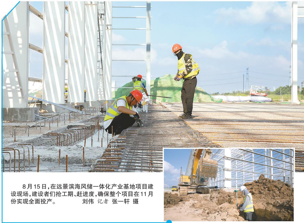
8月15日,在远景区滨海风韵一体化产业基地项目建设现场,建设者们抢工期、赶进度,确保整个项目在11月份实现全面投产。 刘伟 记者 张一轩 摄
