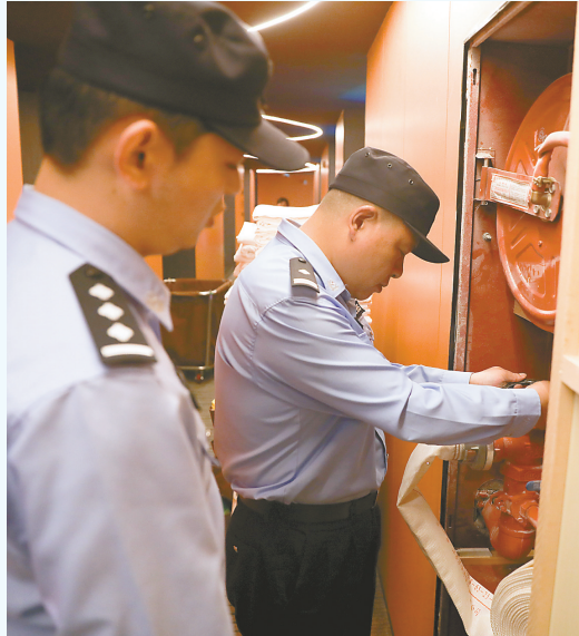
检查消防设备
