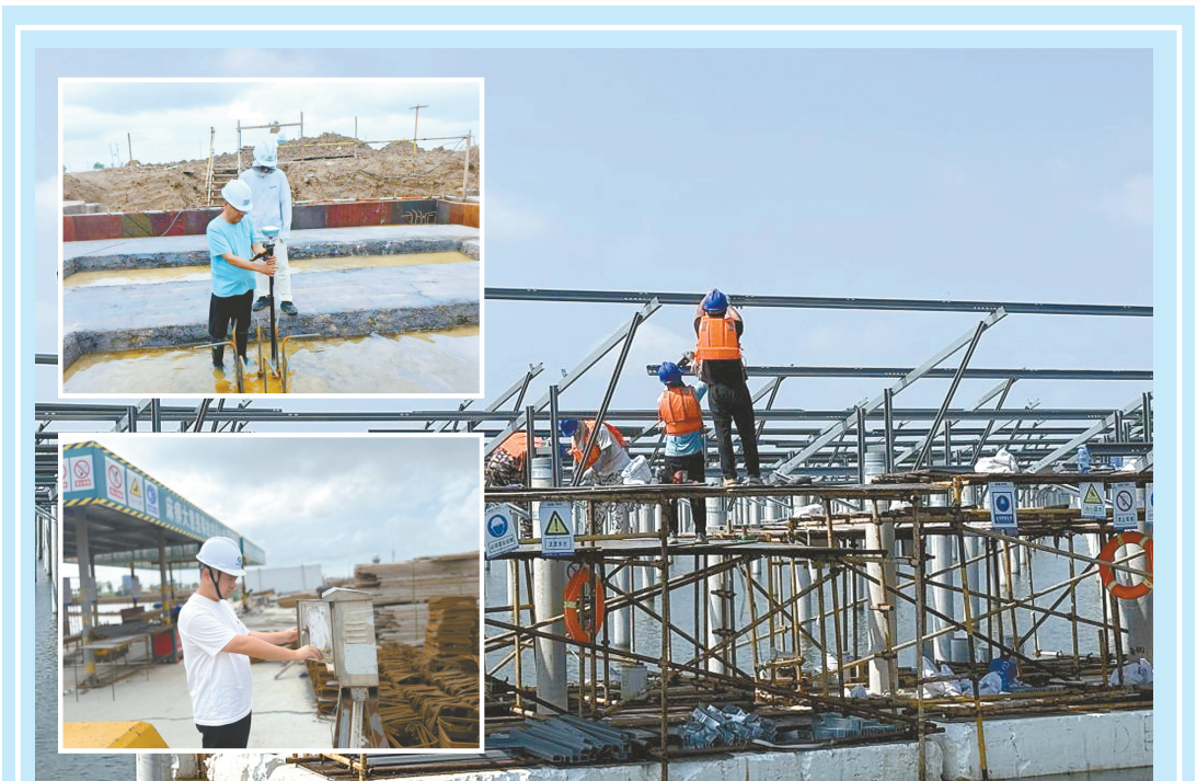
近日,在黄海新区悦悦420MW和兴东120MW渔光互补光伏发电项目现场,盐城市海兴新能源发展有限公司的建设者在烈日下挥洒汗水,坚守岗位,全力保障绿色能源建设。
