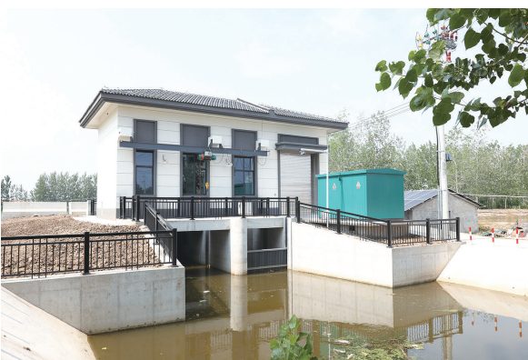
新建的长滩泵站
