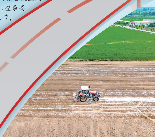
正在进行中的路基灰土施工
