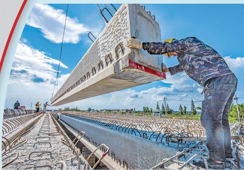
工人在安装空心板梁
