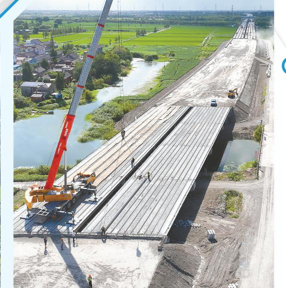
7月22日下午3点30分，在东兴高速公路东台段杨家舍中桥施工现场，随着最后一块空心板梁稳稳落地，主线最后一座桥的梁体完成架设，全长24.6公里的东台段主线实现贯通。东兴高速公路东台段是江苏省“十五射六纵十横”高速路网的重要联络线，概算投资47.65亿元。目前，项目软基处理、路基土石方、小型构造物、桥梁桩基和下部结构砼、上部现浇砼全部完成，累计完成投资28.74亿元，占总投资的60%。
