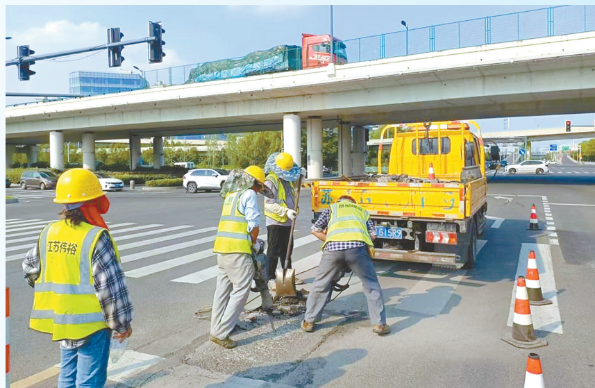
维修破损路面
