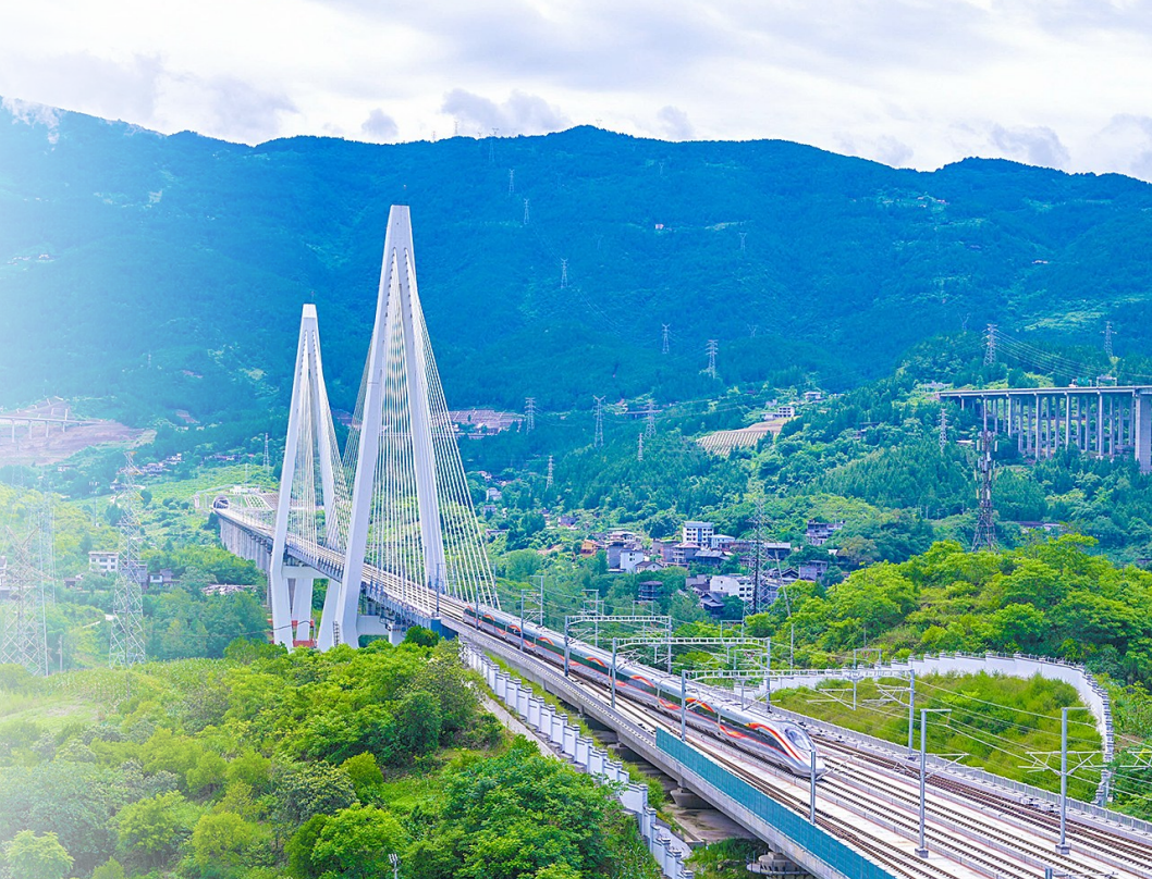
图为当日首发高铁班列驶过渝厦高铁武陵太子坪乌江大桥(无人机照片)。 新华社发 敬凡 摄
