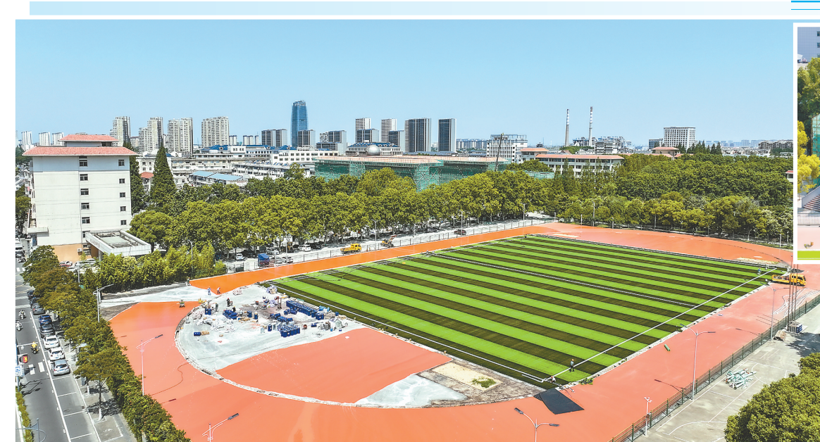
6月17日上午，在盐城中学老校区操场上，工人正在铺设塑胶跑道和人工草皮。盐中老校区本次改造从5月20日设计开工，8月底交付使用，改造涵盖教学楼、图书馆、科技楼、体育馆、宿舍等建筑的内外墙出新、屋面改造、门窗更换及修缮。 记者 王焱 摄
